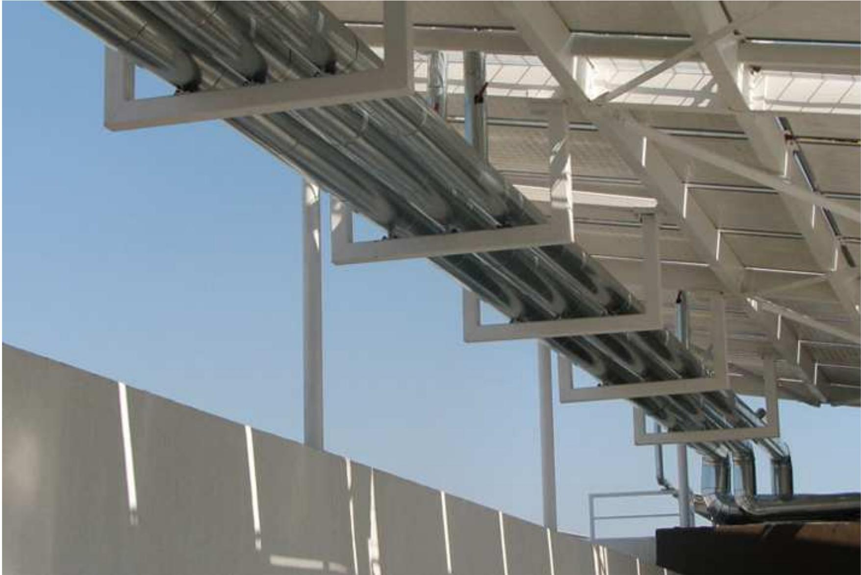
Correcta Aislación de tuberías en el exterior.
