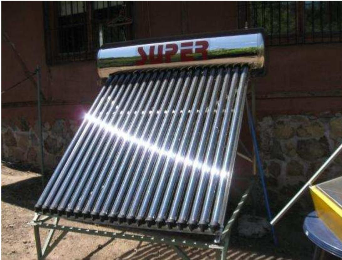
Colector de Tubo al Vacío Tipo Heat Pipe.
