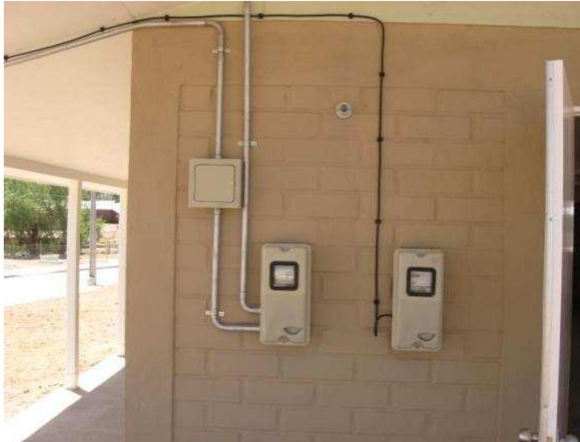
Medidor de Consumo y de Conexión a Red de SFV con Fusibles de desconexión de sistema
