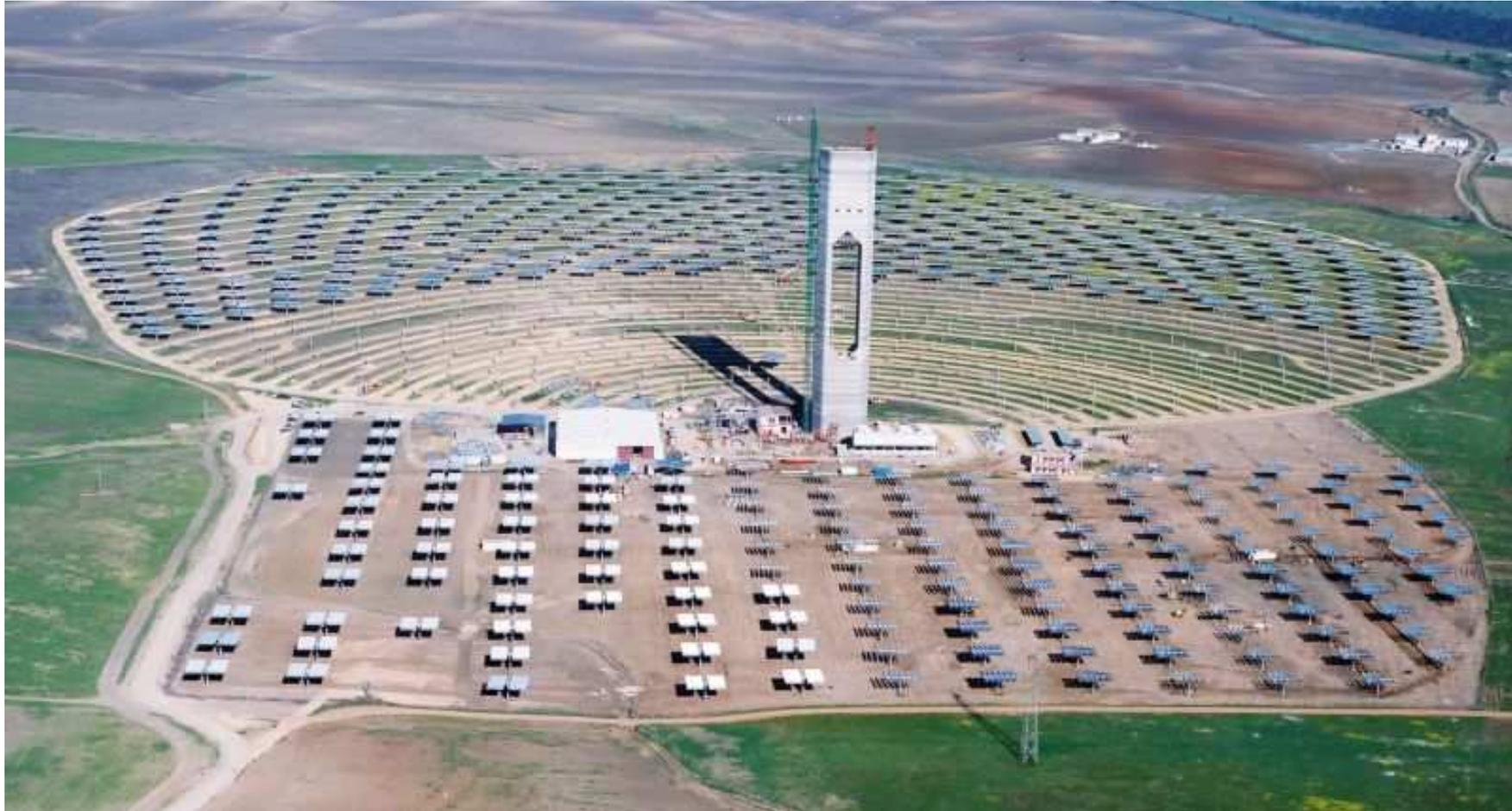
Planta Solar PS10 de 11 MW en Sevilla, España. En línea desde Octubre. Crecerá hasta 300 MW. Costo de generación por debajo de los US\$0,08/kWh
