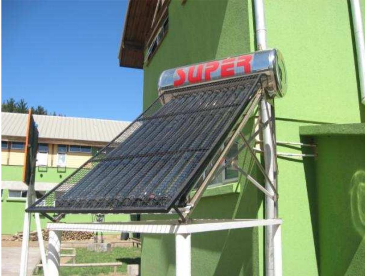
Este tiene estanque de 120 lts de capacidad. Soporta presión de la red. Como usa el principio de “heat pipe” está protegido de congelamiento. Bajo costo. Instalado en un Internado de Cobquecura. Además posee malla protectora
