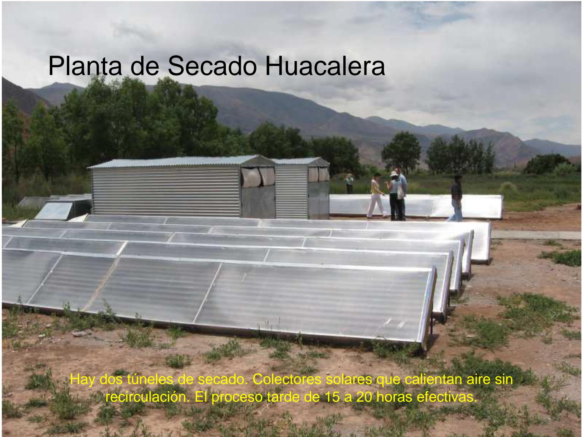
Hay dos túneles de secado. Colectores solares que calientan aire sin recirculación. El proceso tarde de 15 a 20 horas efectivas.
