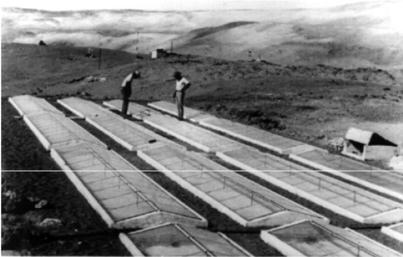
*Planta destiladora de 100 [m<sup>2</sup>] funcionando en Quillagua, desierto de Atacama, 1966*
