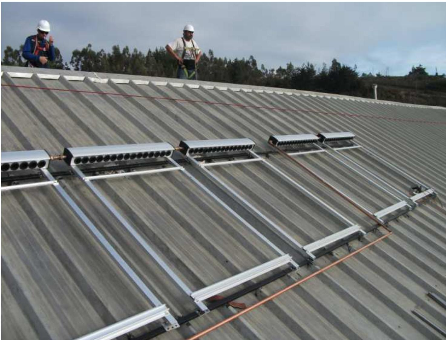
7,5 mts<sup>2</sup> colectores de tubo al vacio – 500 lts acumulación solar – precalentado agua ingreso a termos (25% reducción consumo GLP)
