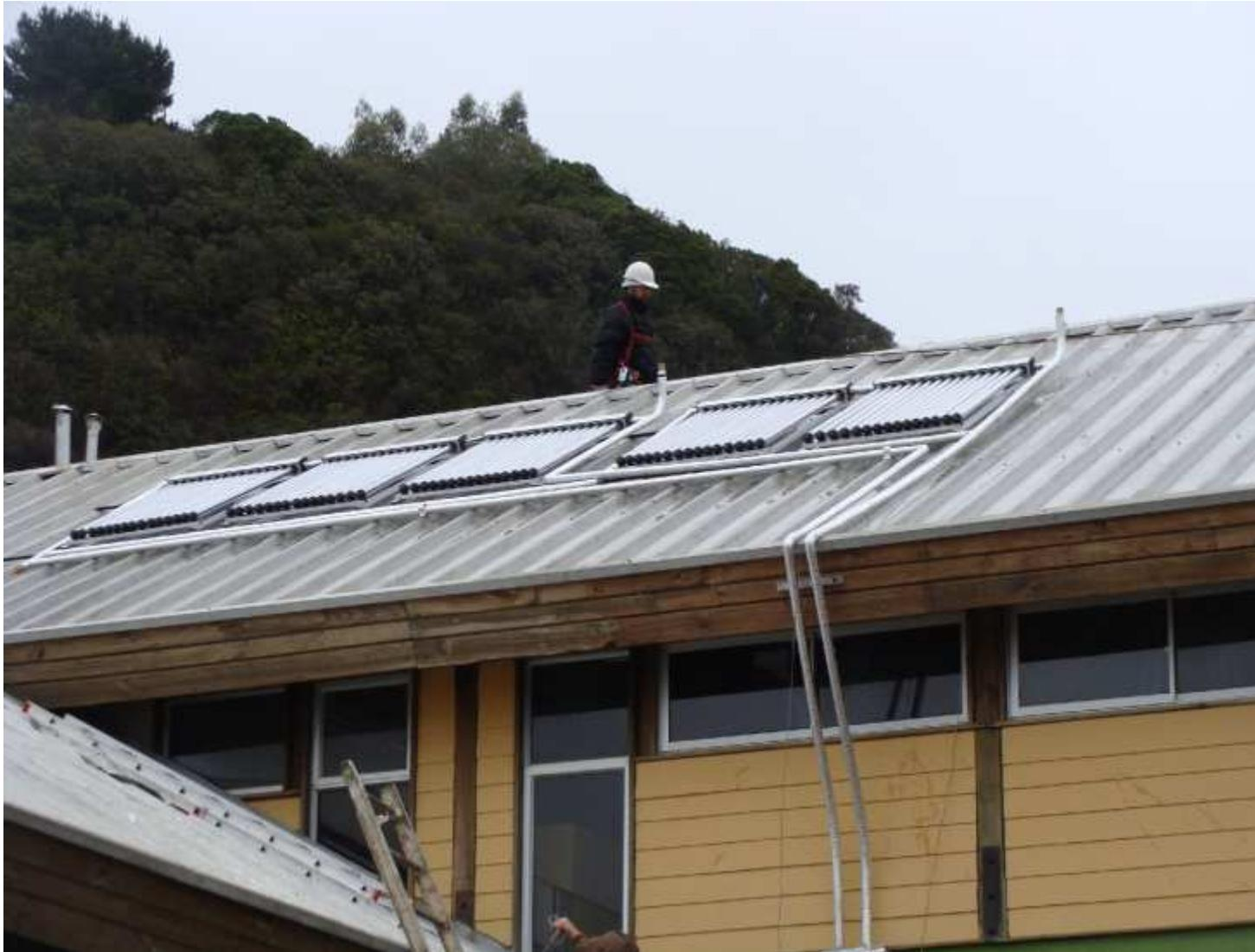
7,5 mts<sup>2</sup> colectores de tubo al vacio – 500 lts acumulación solar – precalentado agua ingreso a termos (25% reducción consumo GLP)
